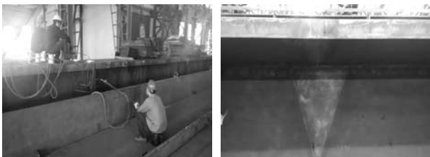
图 19 采用三角法火焰矫正↑
