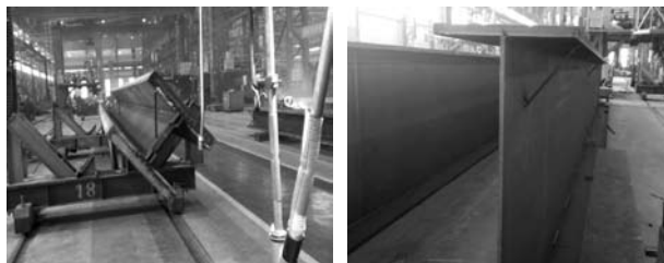
图 13 焊接 H 型钢埋弧焊前通过点焊拉杆固定的方式减少焊接变形 ↑
